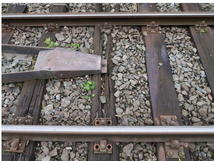
Foto č. 3 Železniční svršek – výběh začátek – prohnílé pražce a chybějící vrtule
