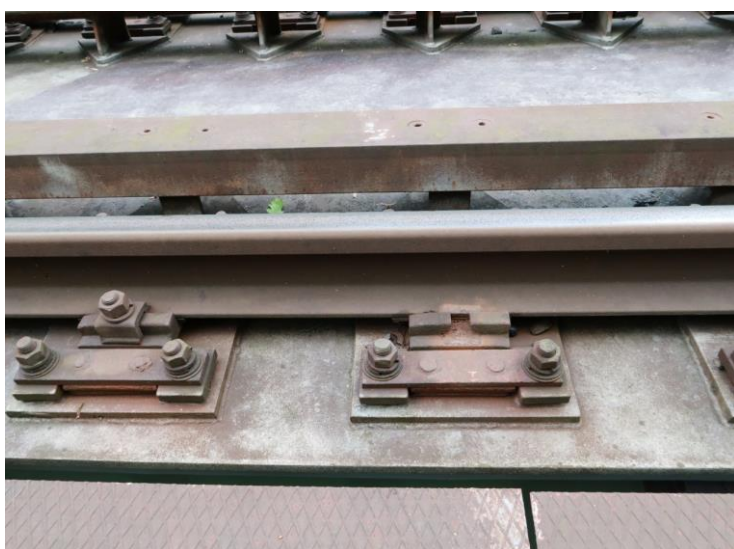
Foto č. 2 Železniční svršek – 36. svěrka vpravo vně na K 01 – chybí
