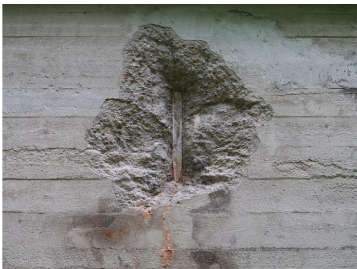
Foto č. 1 Opěra O 01 – křídlo vpravo – degradovaný beton
